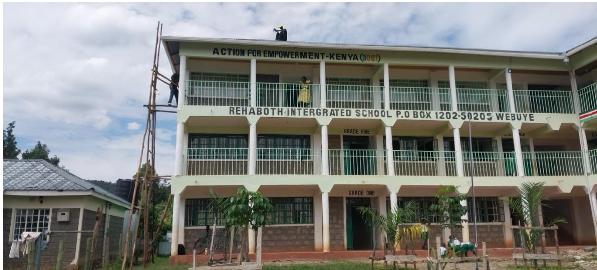
Auf dem Schuldach konnten Dachrinnen installiert werden.
