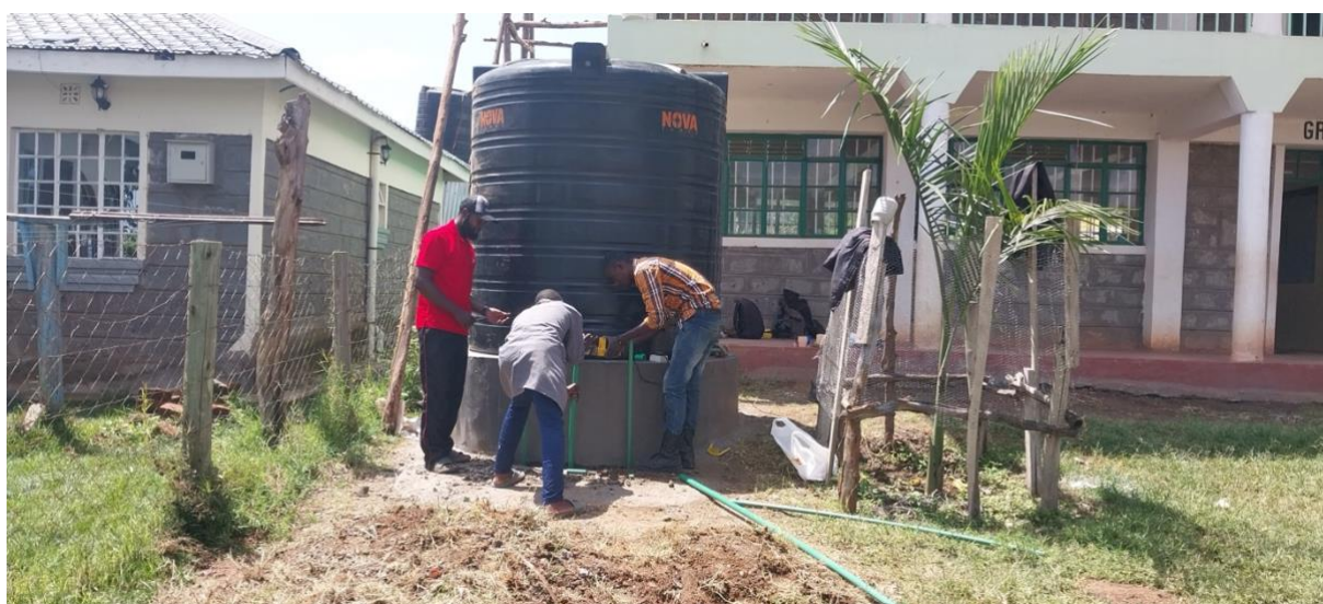
Ein großer Tank fängt Regenwasser auf, das hilft, beim Wassersparen.
