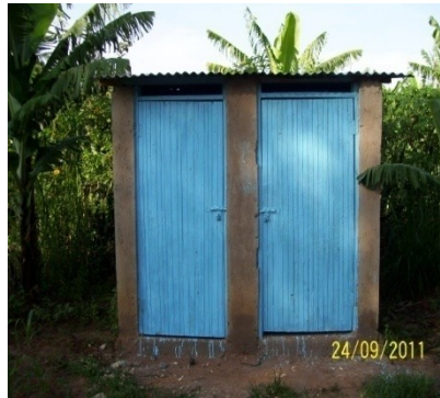
Neue Toilette und Waschraum
