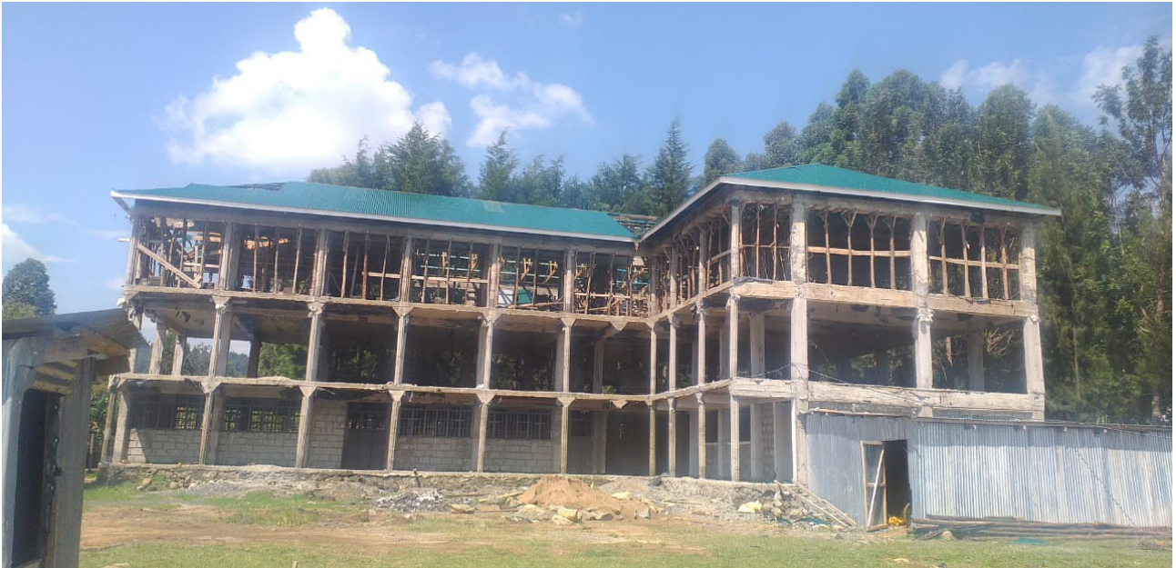
Grund zur Dankbarkeit: Unser Schulbau geht mit großen Schritten voran
