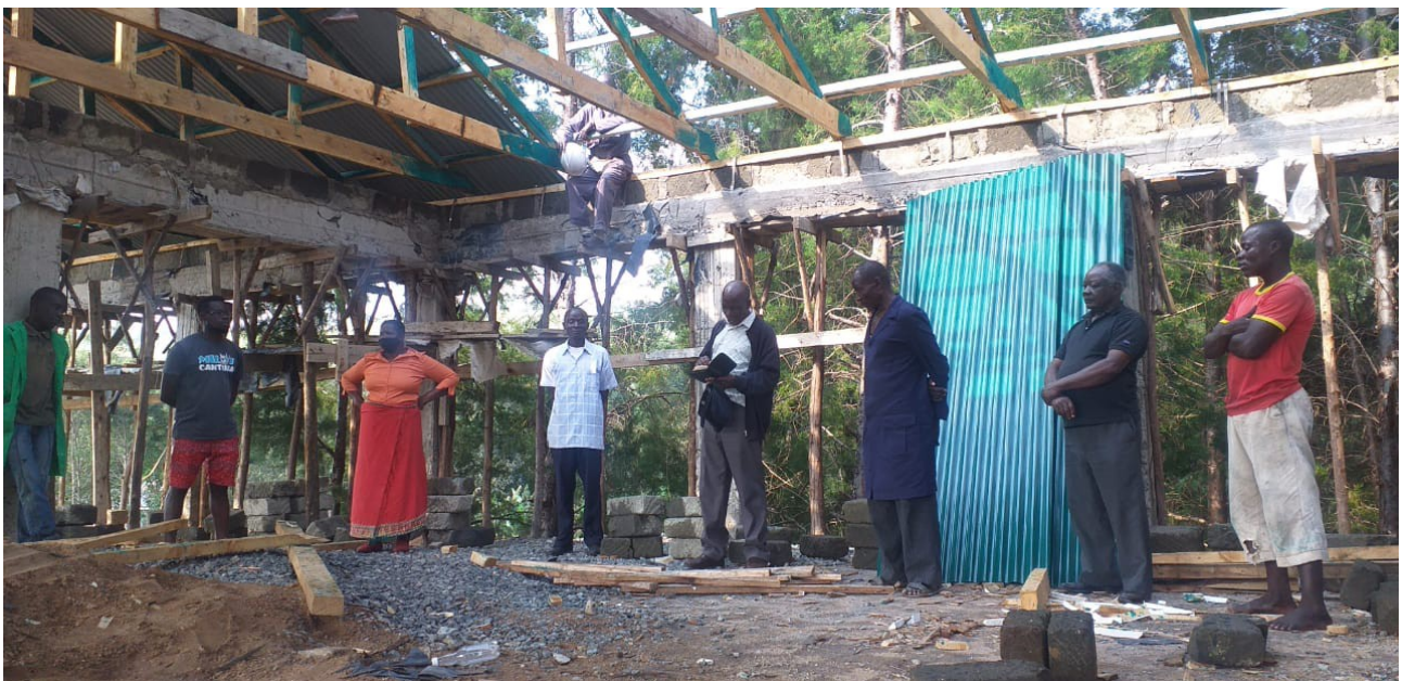
Gebet beim Richtfest auf der Baustelle
