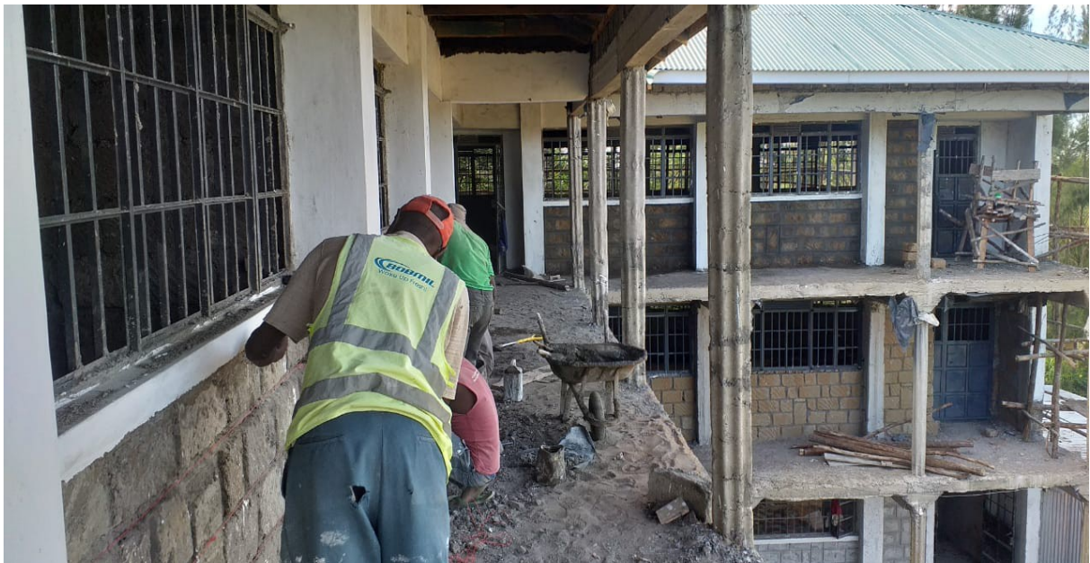
Derzeit werden an unserer Rehabot-Grundschule die Außenwände verkleidet
